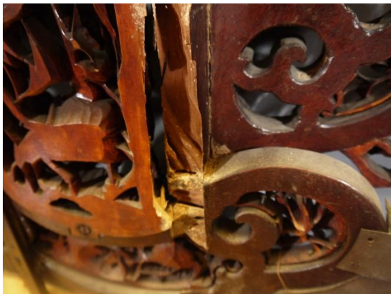
有白蟻蛀蝕痕跡、構件鬆脫、木材開裂等情形
