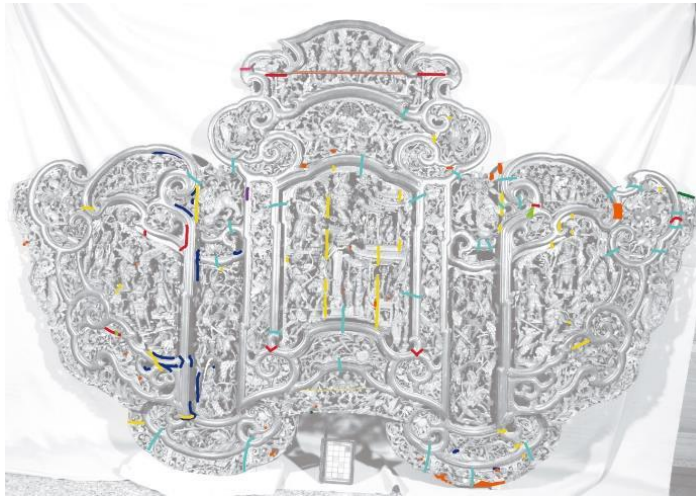
圖 7-1-15 彩牌正面劣化狀況標示（本研究團隊拍攝）
