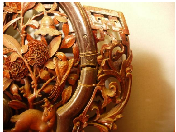
有白蟻蛀蝕痕跡、構件鬆脫、木材開裂等情形
