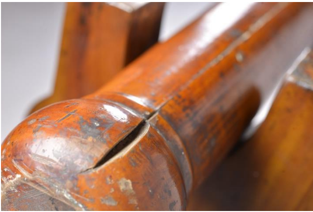
木材有髓心開裂情形
